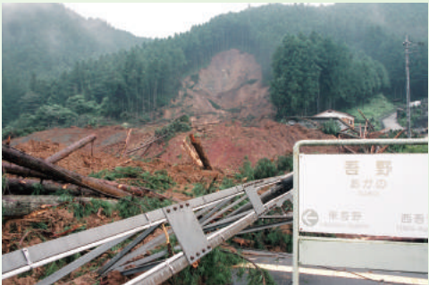
吾野駅に迫る斜面崩壊の土砂 奥の山肌が斜面崩落した。
