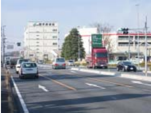
(入間市) 国道16号沿道
