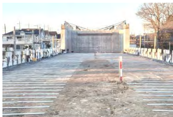
③南側補強土壁工事状況
