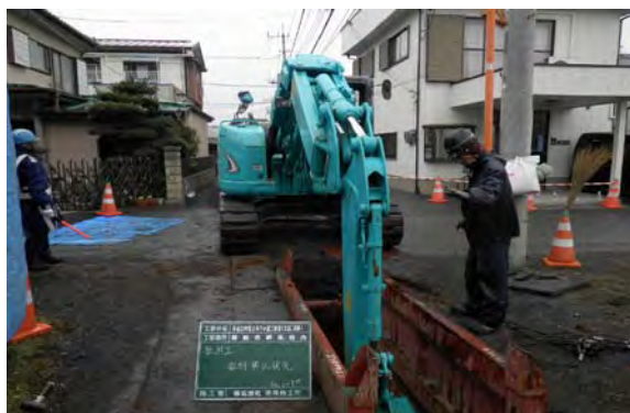
下水道管の布設工事の様子
