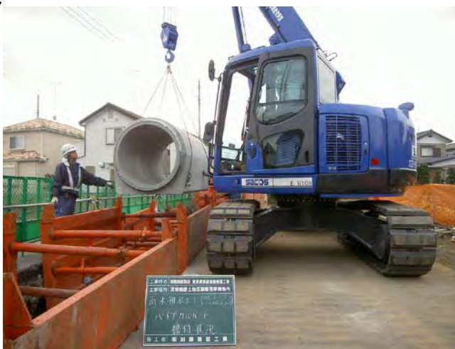
雨水管の設置状況（東原巽原線）
