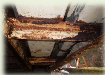
腐食 塗装が腐食している状態
